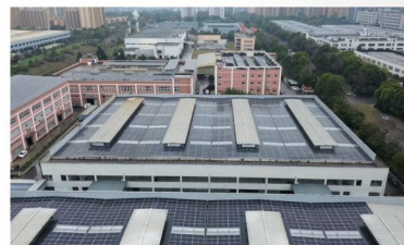
► 四通机械1.7MW屋顶光伏
