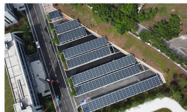
► 重庆江津区1MWh光伏储能充电项目
