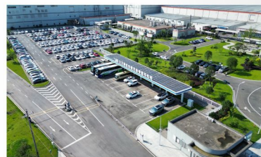
► 四川时代光储充检一体化电站
