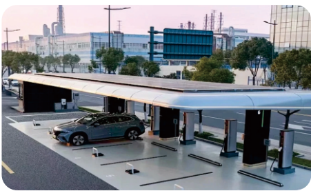
新能源充电站
